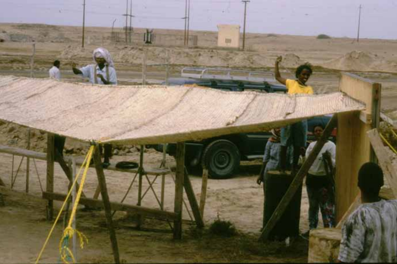
图 8. Using native materials, workers fabricate prototype for shrimp pond shade system at the Seawater Farm, Massawa, Eritria, East Africa. 东非 Eritria 的 Massawa 海水农场，利用自然材料，工人们建造的虾池遮阳系统原型。
