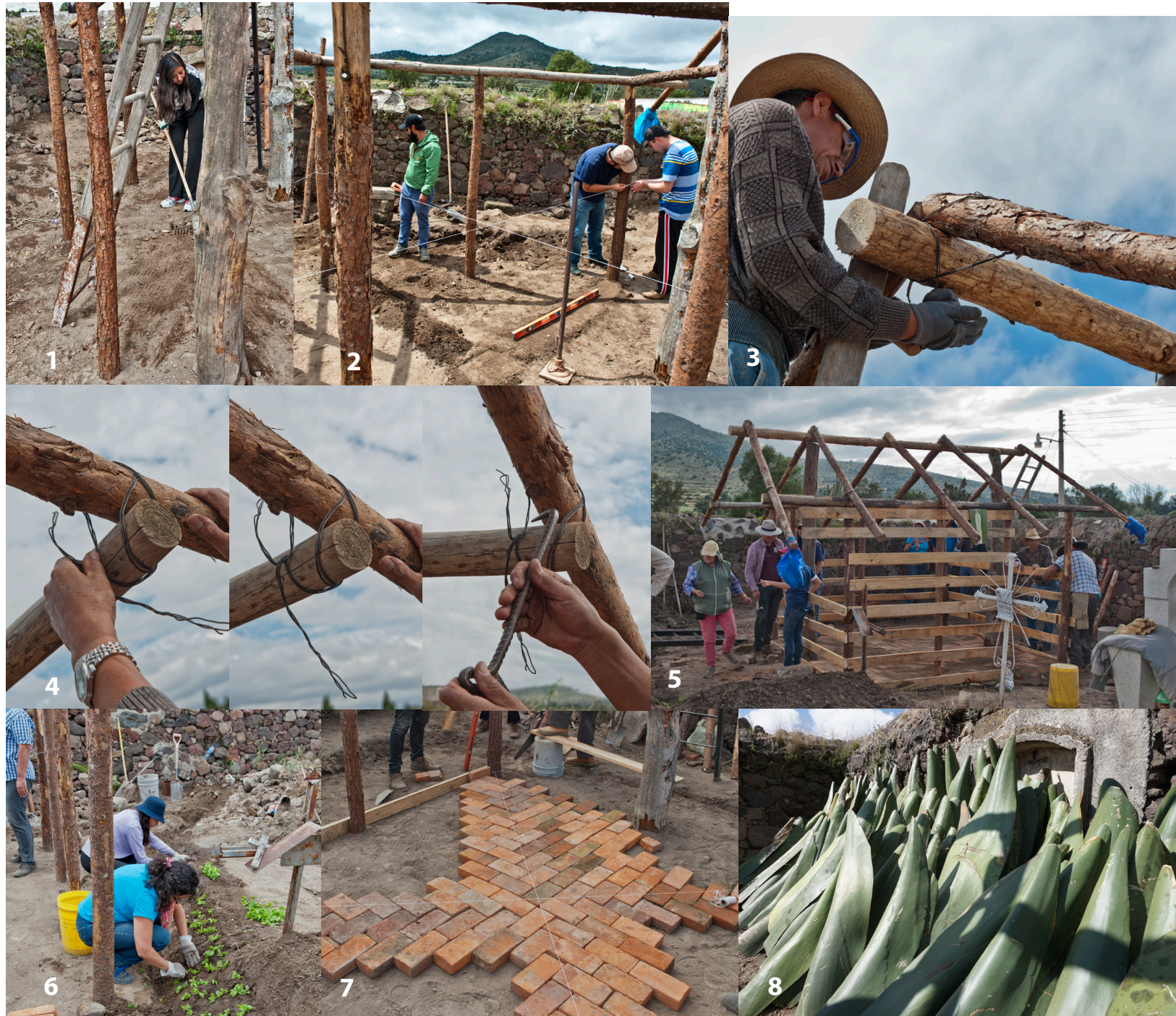
1. Incado de esquinas y horcones / 2. Nivelación / 3. Centro del techo / 4. Terminación de la estructura / 5. Colocación de las cintas/ 6. Tratamiento de talud / 7. Colocación de piso / 8. Ranchito
