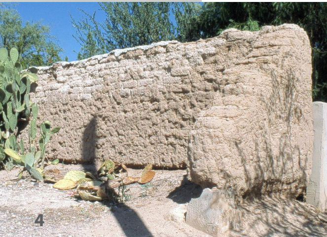
1. Granulometría / 2. Daños y sus agentes / 3. Desprendimientos / 4. Erosión basal y superficial/ 5. Grietas / 6. Plantas
